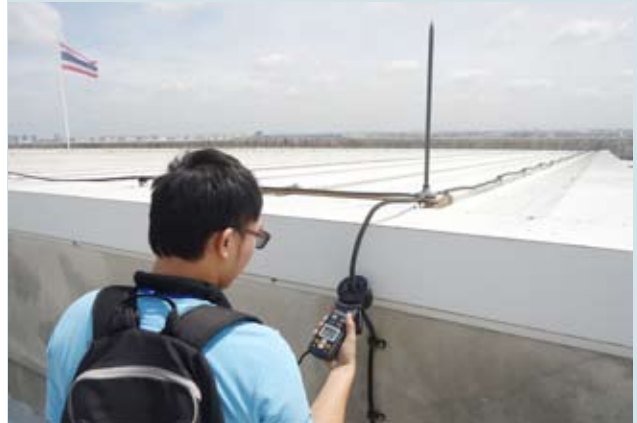
ตรวจสอบระบบป้องกันฟ้าผ่า
