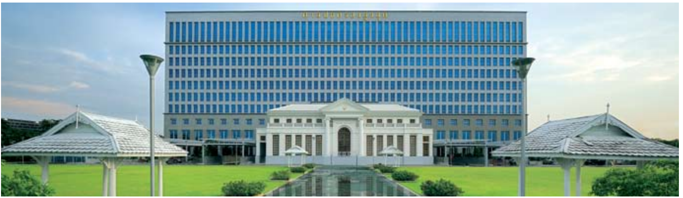
ภาพพื้นที่ก่อสร้างบริเวณโซนเอ เดือนธันวาคม 2552
