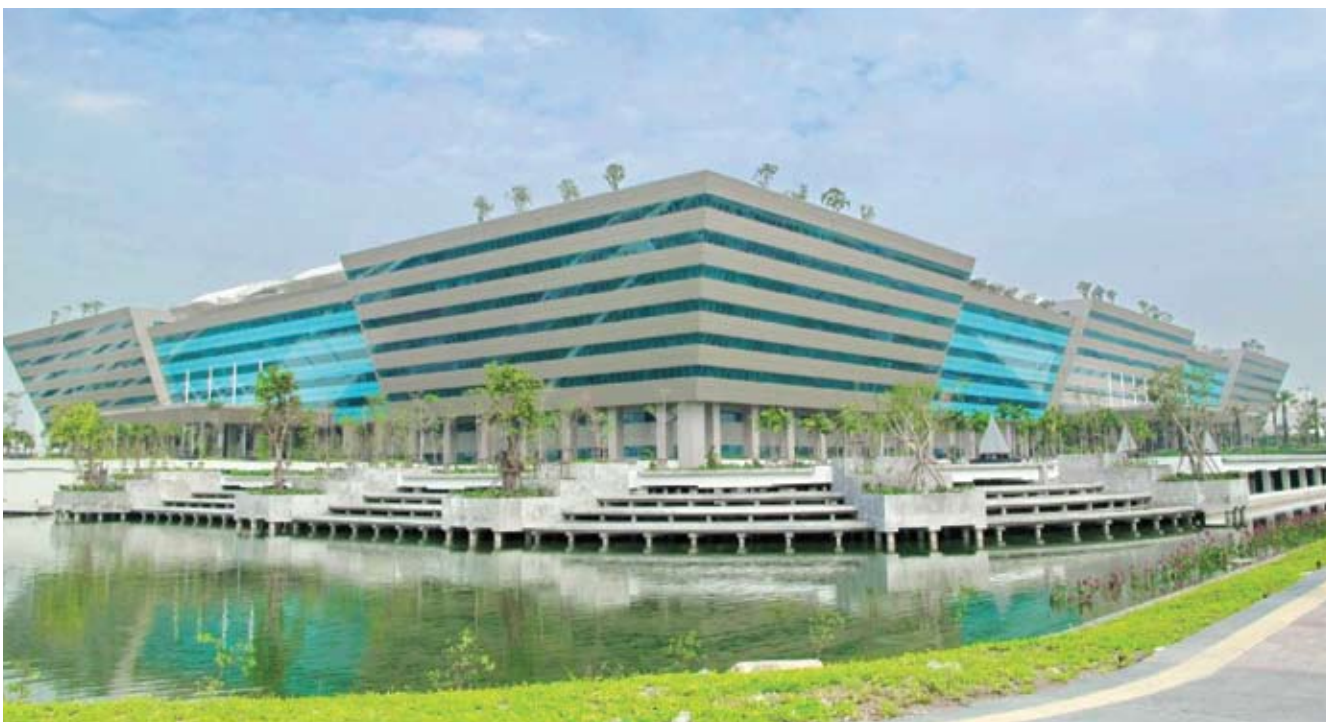
ภาพการก่อสร้าง ด้านทิศตะวันออกอาคารบี สัญญา 3 ธันวาคม 2552
