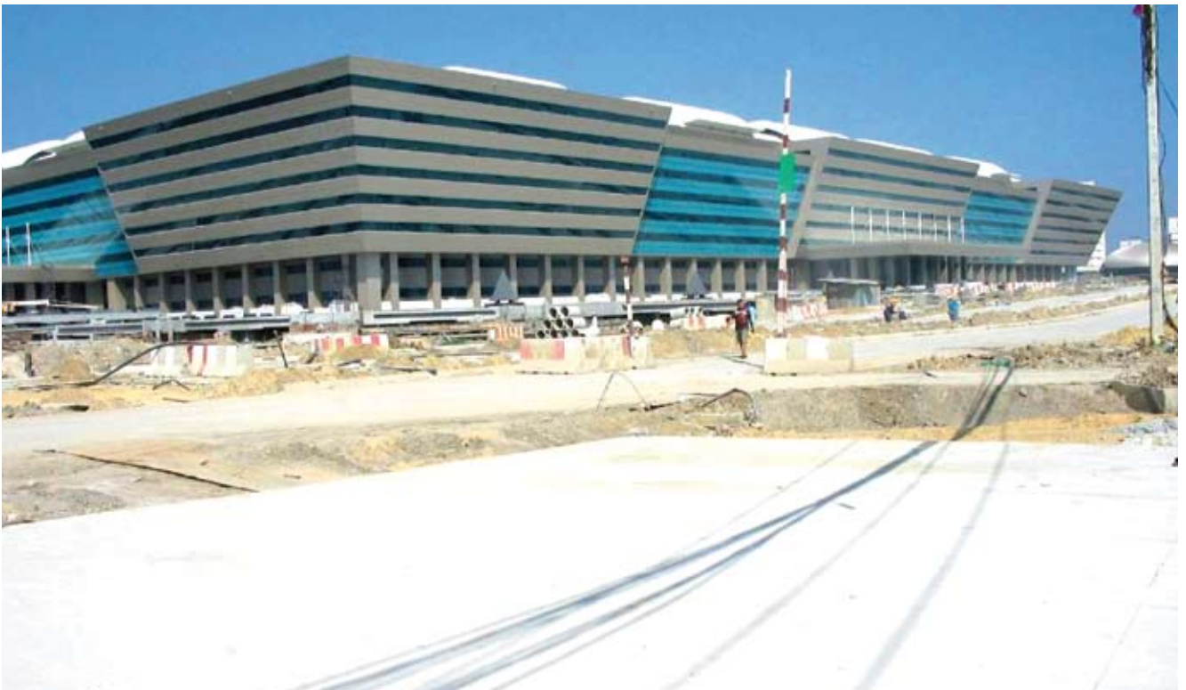
ภาพการก่อสร้าง ด้านทิศตะวันออกอาคารบี สัญญา 3 ธันวาคม 2551
