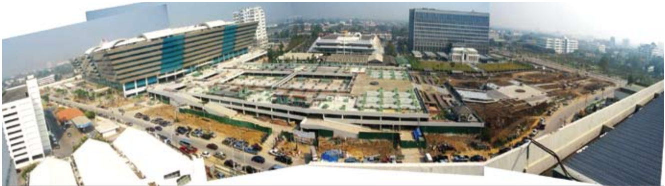
สภาพพื้นที่ก่อสร้างบริเวณโซนเอ เดือนธันวาคม 2551
