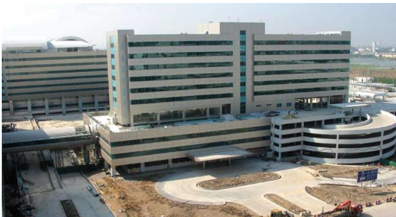
ภาพการก่อสร้างหอพักและอาคารจอดรถบี สัญญา 4 เดือนธันวาคม 2551
