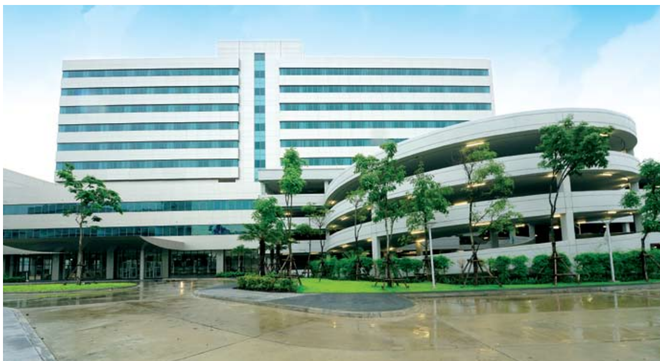
ภาพการก่อสร้างหอพักและอาคารจอดรถบี สัญญา 4 เดือนธันวาคม 2552
