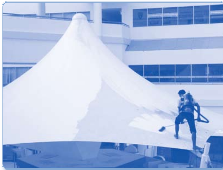
ทำความสะอาดหลังคาโดมร้านขายของ
