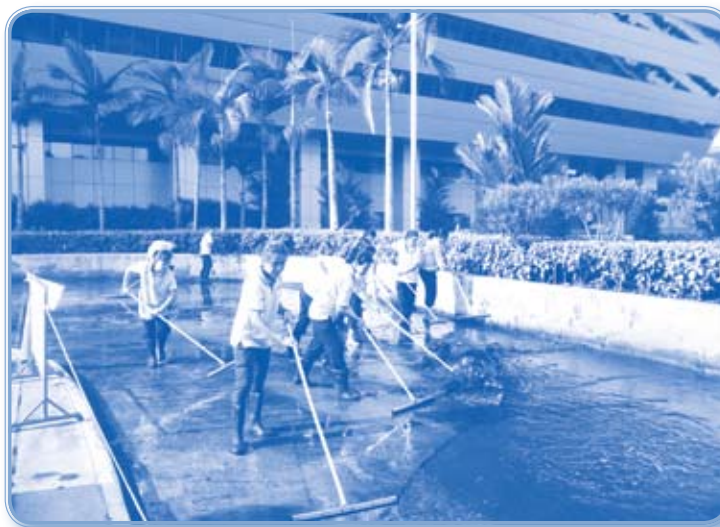
ขัดล้างพื้นถนนรอบอาคาร
