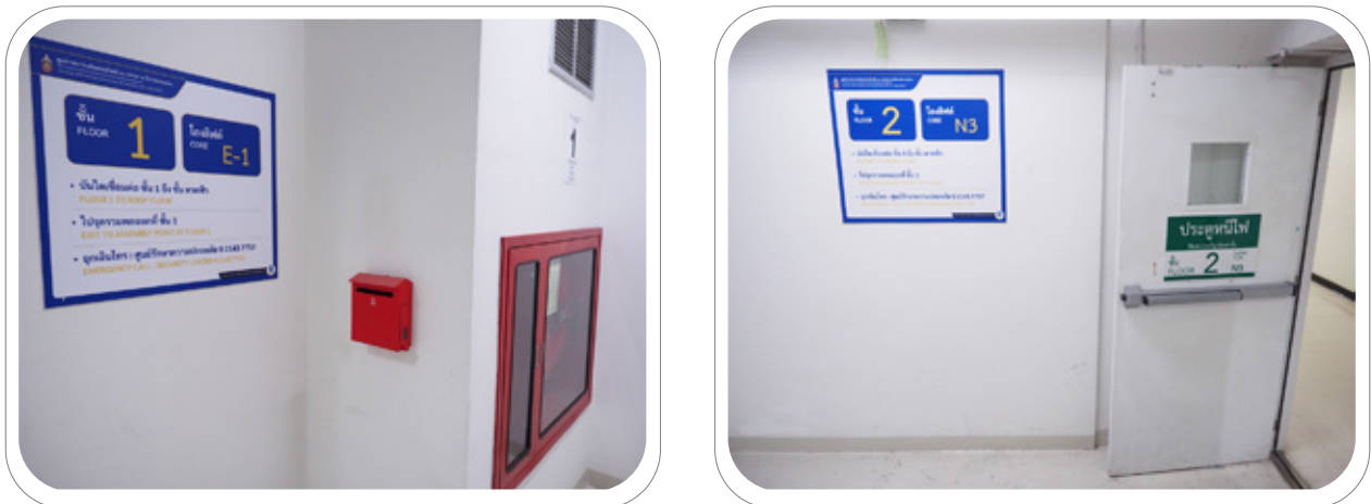
รูปภาพการติดตั้งป้ายประตูหนีไฟและป้าย Fire Safety
