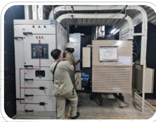
ตรวจสอบความปลอดภัยห้องระบบไฟฟ้า
